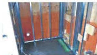
⑥内部躯体構造
