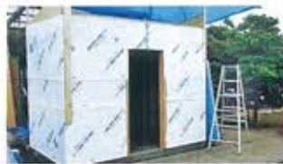
⑦外壁下地施工
