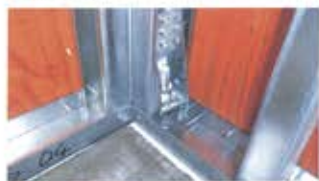
⑤アンカー固定
