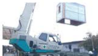
③吊り上げ
