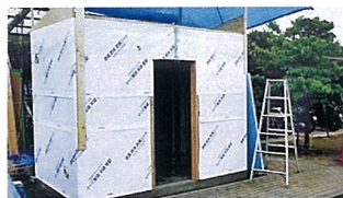
⑦外壁下地施工
