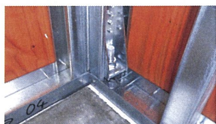
⑤アンカー固定
