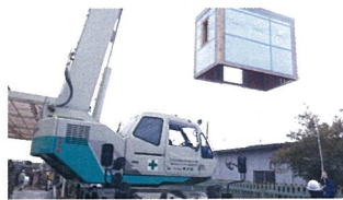
③吊り上げ
